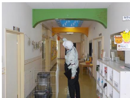
室内点検の様子①
