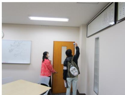
室内点検の様子②
